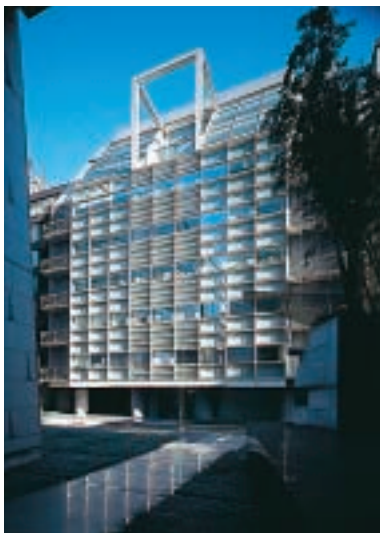
本 社(兼松ビル別館)
