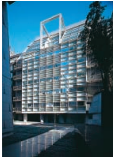
本社(兼松ビル別館)
