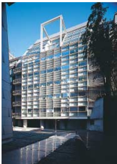
本 社 (兼松ビル別館)
