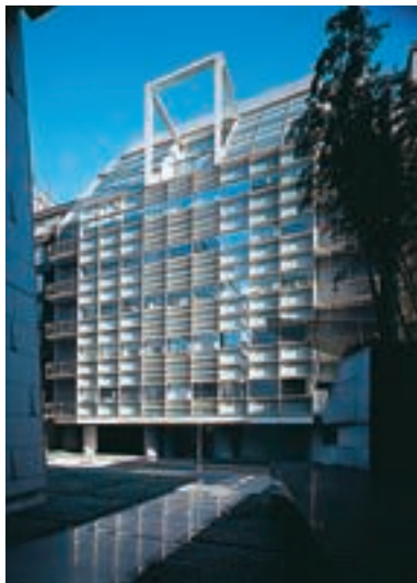
本 社(兼松ビル別館)
